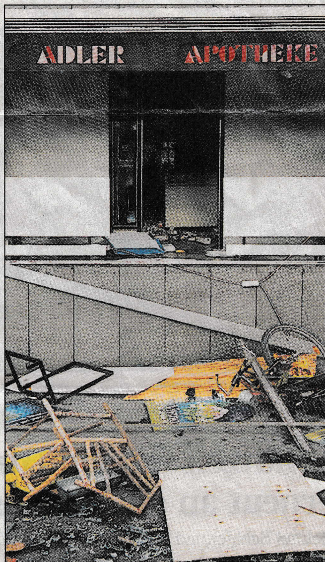
Die Schaufensterscheiben wurden durch die Druckwelle herausgeschleudert und splitterten, Passanten wurden verletzt.
